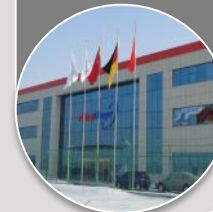
Changchun, China Neues Produktions- gebäude
